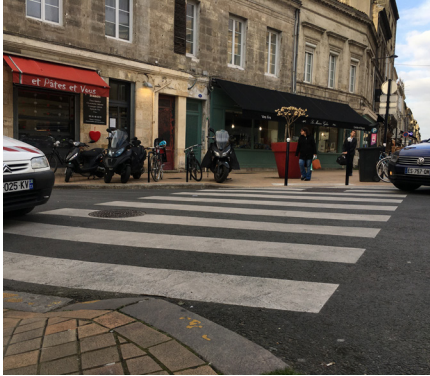
Assurer la continuité des trottoirs Cours Portal, Bordeaux. Crédit : a'urba
